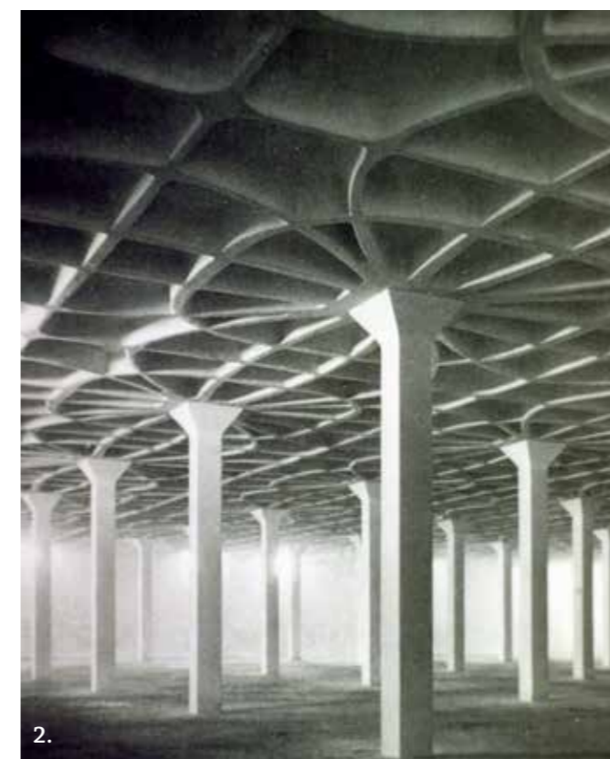
2. Topologie-geoptimaliseerde ribconstructies ontworpen door Pier Luigi Nervi; Gatti wolfabriek (Rome, 1951).
